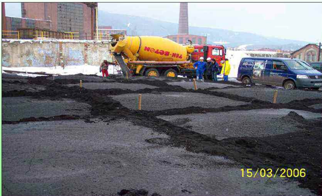
Fertigstellung der Versuchsfelder
