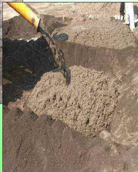
Einfüllen des Gemisches in die Versuchsfelder
