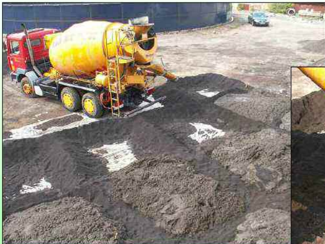
Einfüllen des Gemisches in die Versuchsfelder
