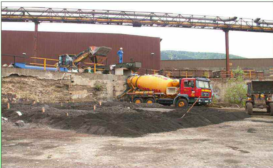
Einfüllen des Gemisches in den gering mit Wasser gefüllten Fahrnischer 16
