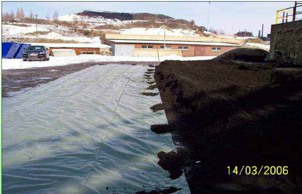
Anlegen der Versuchsfelder mittels Untergrundabdichtung (Folie)
